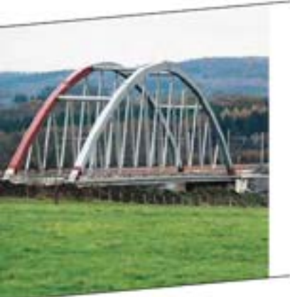
Het uitbouwen van een moderne infrastructuur: een van de doelstellingen van Infrabel
